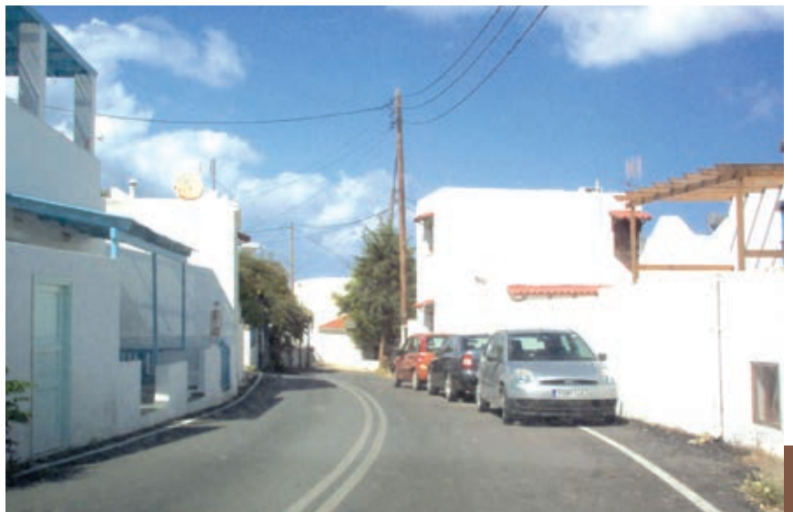
Από το έργο της Βελτίωσης δρόμων περιοχής Λιβαδίων
